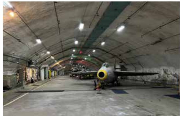
Bild: Interiör från en av två stora tunnlar ned till hangarerna inne i berget. Tunnlarna tjänade även som uppställningsplats för de klargjorda planen. I bilden syns en J29 Tunnan från 2:a divisionen. Notera sprinklersystemet i taket och längs väggarna. I händelse av brand kunde ytorna släckas med skum. Illustration från berghangar Aeroseumberget, numera Aeroseum, foto: Sven Olof Ahlberg
